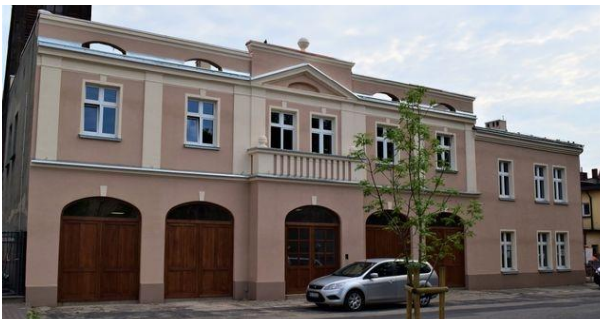
Siedziba Powiatowego Zarządu Dróg w Ostrowie Wielkopolskim
