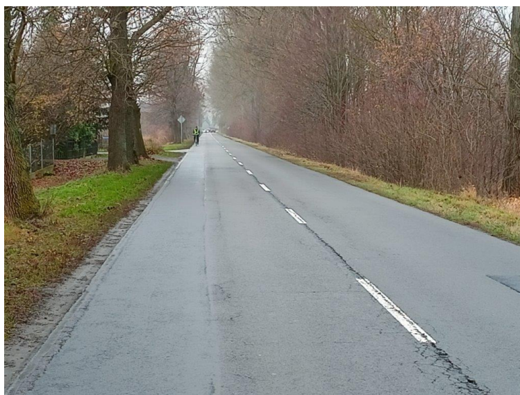
Fot. Zadanie realizowane na drodze Odolanów-Boników
